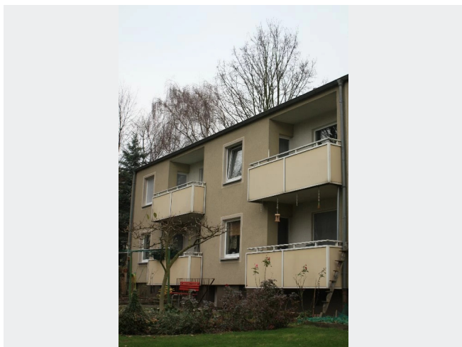
Fassade Gebäude Rückseite
