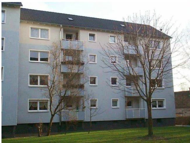
Ansicht hinten Balkone
