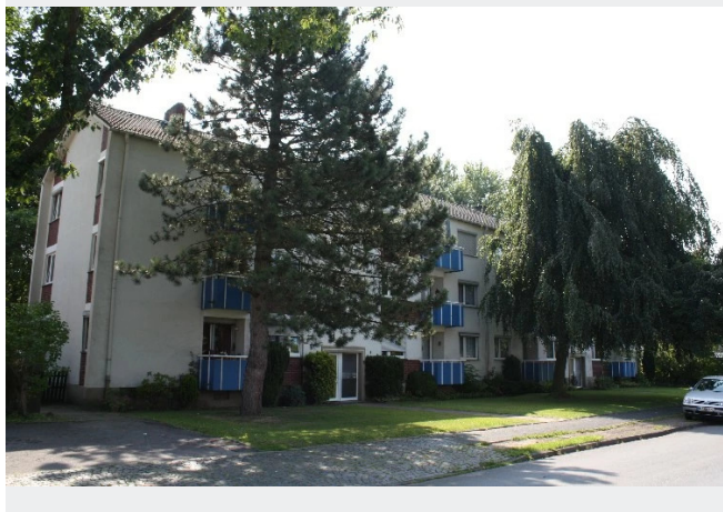
Fassade von Vorn
