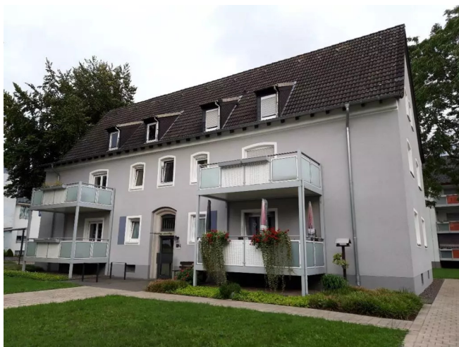
Im Drubbel 2 Strassenansicht
