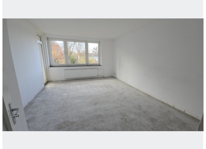
Aktueller Zustand Wohnzimmer
