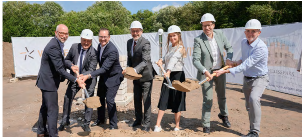
Im April erfolgte der erste Spatenstich mit Vertretern von VIVAWEST und der Eckehard Adams Wohnungsbau GmbH
