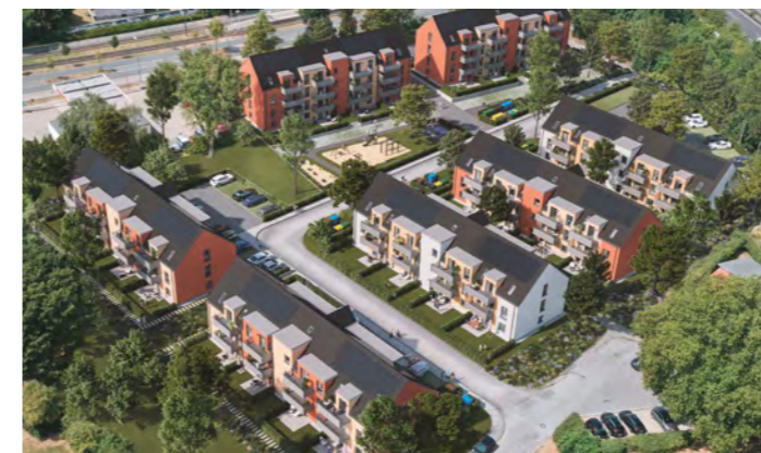
VIVAWEST verwaltet 92 klimafreundliche Neubauwohnungen in Dortmund-Brechten
